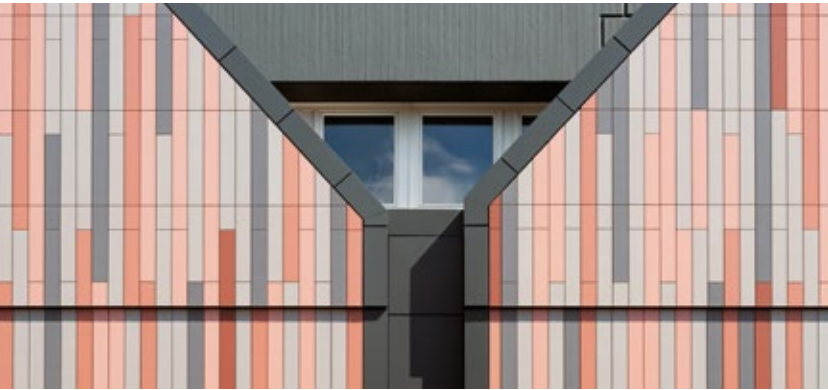
Höxter Markt, Höxter, Germany / Architect: msp architekten GmbH / Year: 2015 / Photo: Mark Wohlrab
